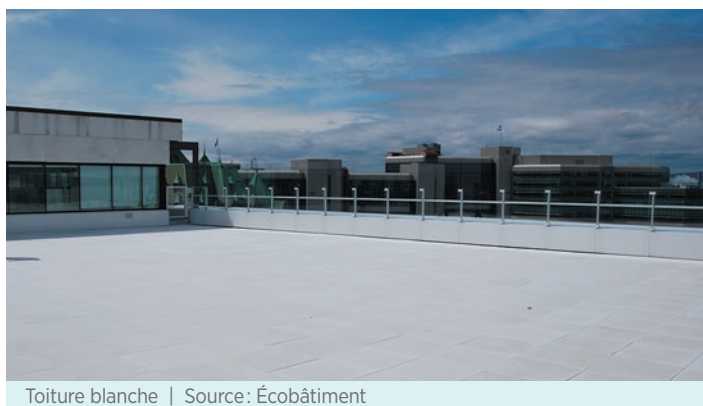
Toiture blanche | Source: Écobâtiment
