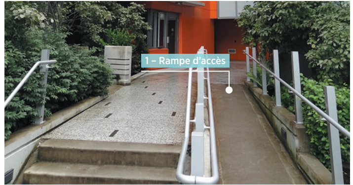
1 - Rampe d'accès Southeast False Creek, Vancouver | Source: Vivre en Ville
