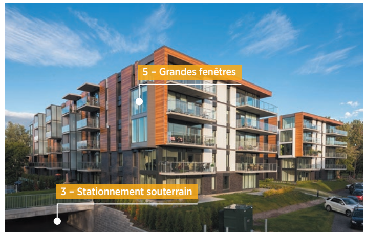
Accès au stationnement souterrain | Source : Stéphane Groleau
