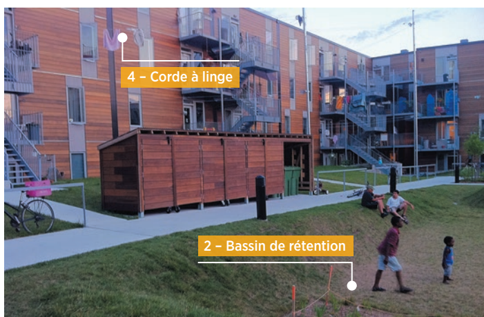
Bassin de rétention servant d'aire de jeux | Source: Vivre en Ville
