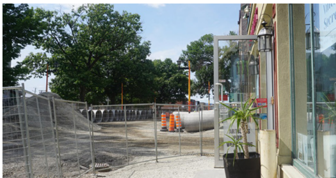
Figure 3.7 TRAVAUX ET CLÔTURES DE CHANTIER
