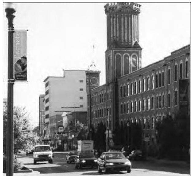
L'édifice de la Fabrique: depuis déjà quelques années, la Ville de Québec y a aménagé son Centre de développement économique et urbain.
