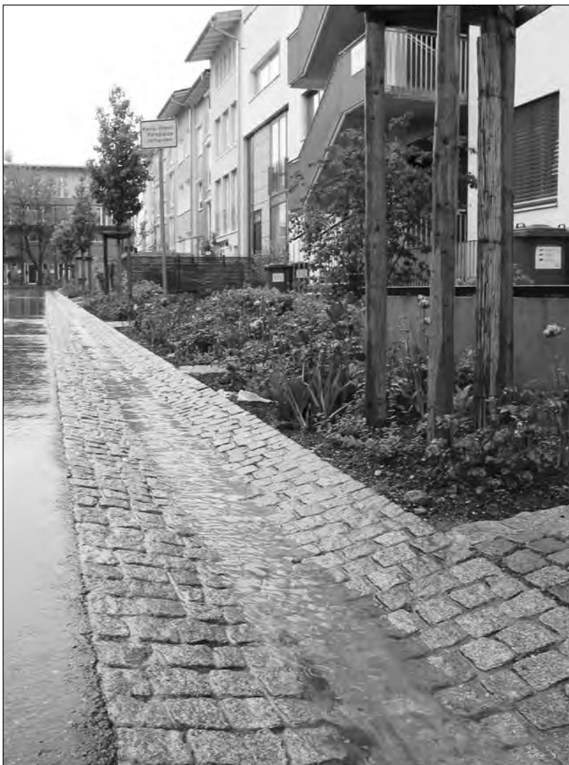
Canal de collecte des eaux de pluie dans le quartier Vauban de Freiburg (Allemagne).
